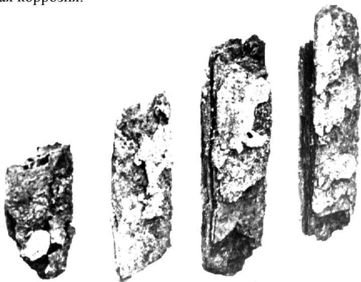
Рис.2. Заземляющая полоса п/ст Пута.
